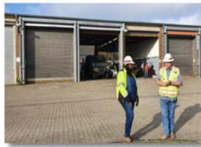
< 저장시설 외부 전경 >
